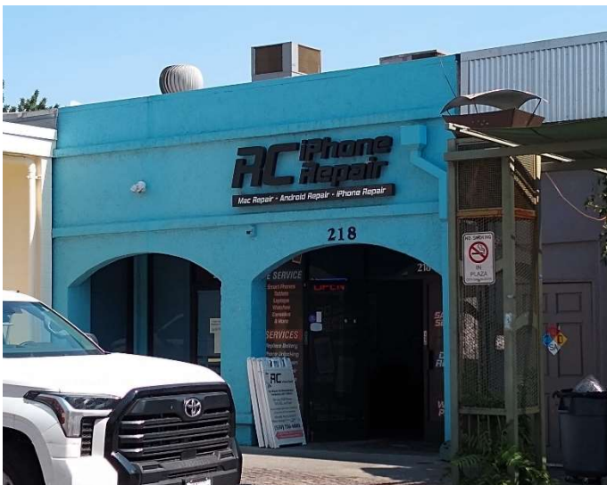
West façade, ESA 2022
